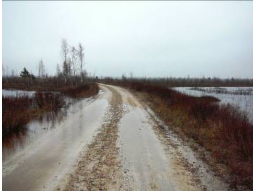
Ceļš nr.6 Būves nr.9 vieta. Viršūdeņi plūst pāri ceļam pēc lietiem 2007.gada decembrī
