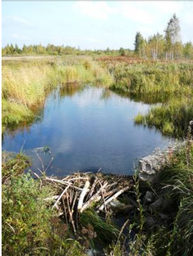
Bebru aizsprostota caurteka C-33.
