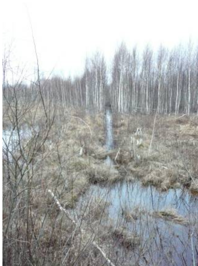
Skats pie caurtekas C-78. Caurtekas gali ir apbērti zem ceļa uzbēruma.
