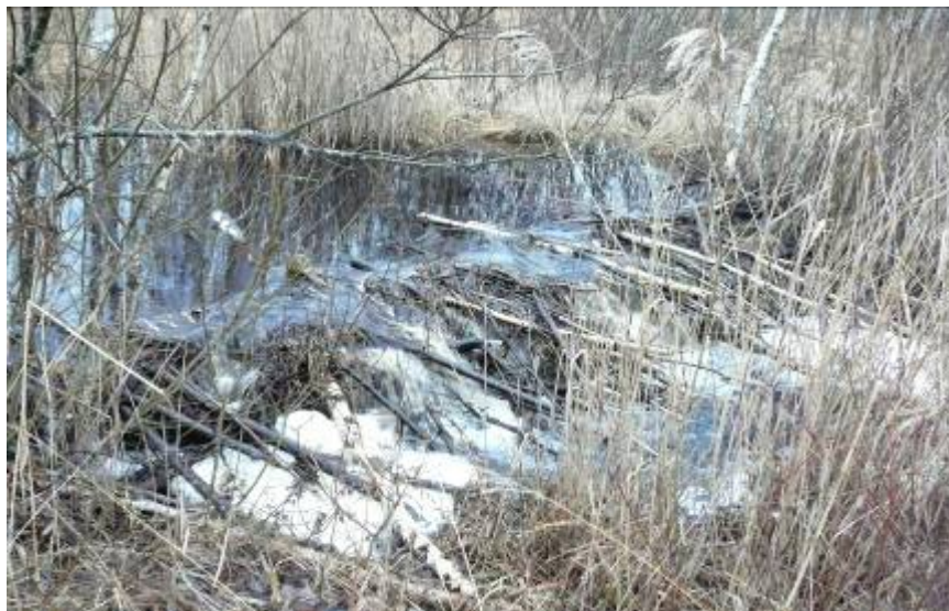
Bebru aizsprosts 0.6m augsts augšpus caurtekas C-79.
